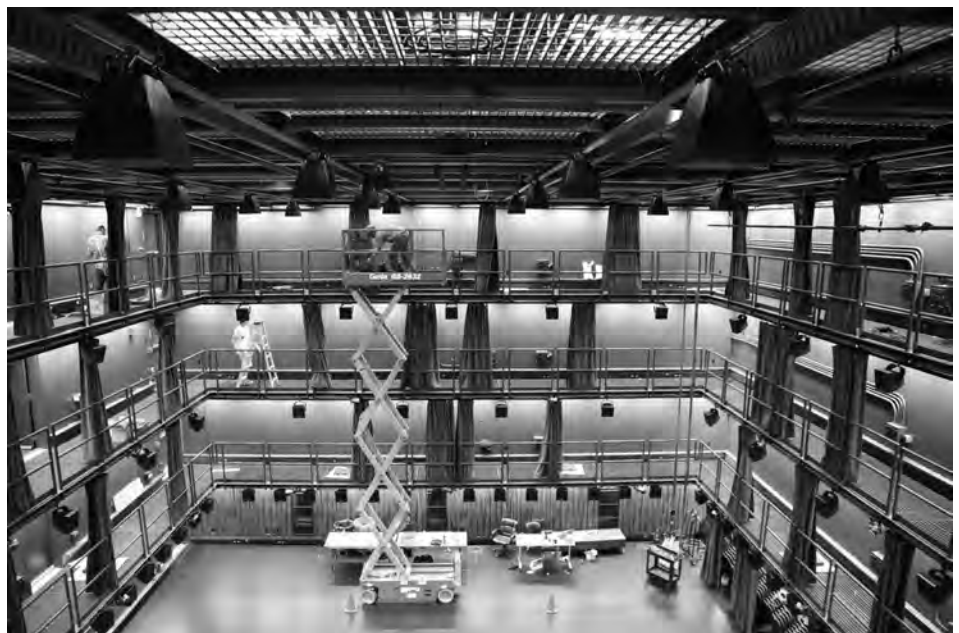
Die audioteknische Infrastruktur des CUBE am Moss Arts Center der Virginia Tech in Blacksburg, VA erlaubt es, ohne größeren rechnerischen Aufwand über 150 Audiokanäle gleichzeitig anzusteuern. (© 2014 Moss Arts Center, Virginia Tech.)
