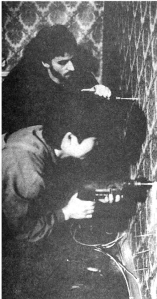
Hämmern und Bohren , Lübecker Str. 21, Berlin-Moabit 1989, Foto: W. v. Kieseritzky
