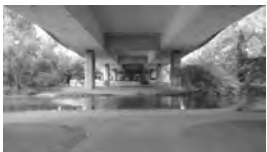
Klangeffekt Adenauerbrücke (links) (alle Fotos: Sam Auinger)
